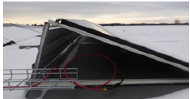
Montage på tak vars bjälklag förstärks.
